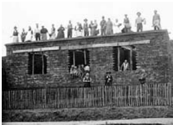
Gradnja obiteljske kuće Sudra
